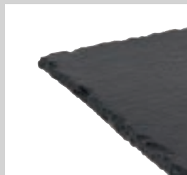
gebrochene Kanten broken edges
